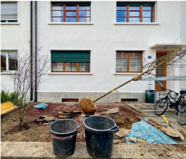
Einfamilienhaus vorher, nachher
